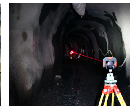
Vortriebskontrolle in Tunnelbau
