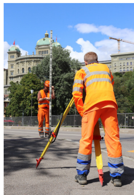
Setzungsmessung mit Präzisionsnivellier
