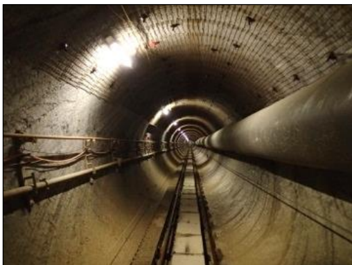
Ausbruch Druckschacht (Ø = 5.20 m, 85%)
