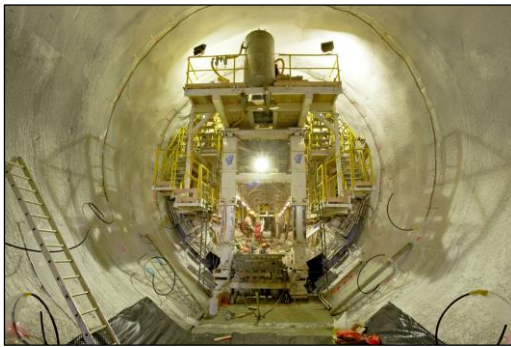
Schalung Oberwasserdruckstollen (Ø = 8.0 m)
