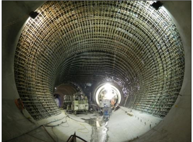
Oberwasserverteilstollen Ø = 8.0 / 2 x 5.50 m
