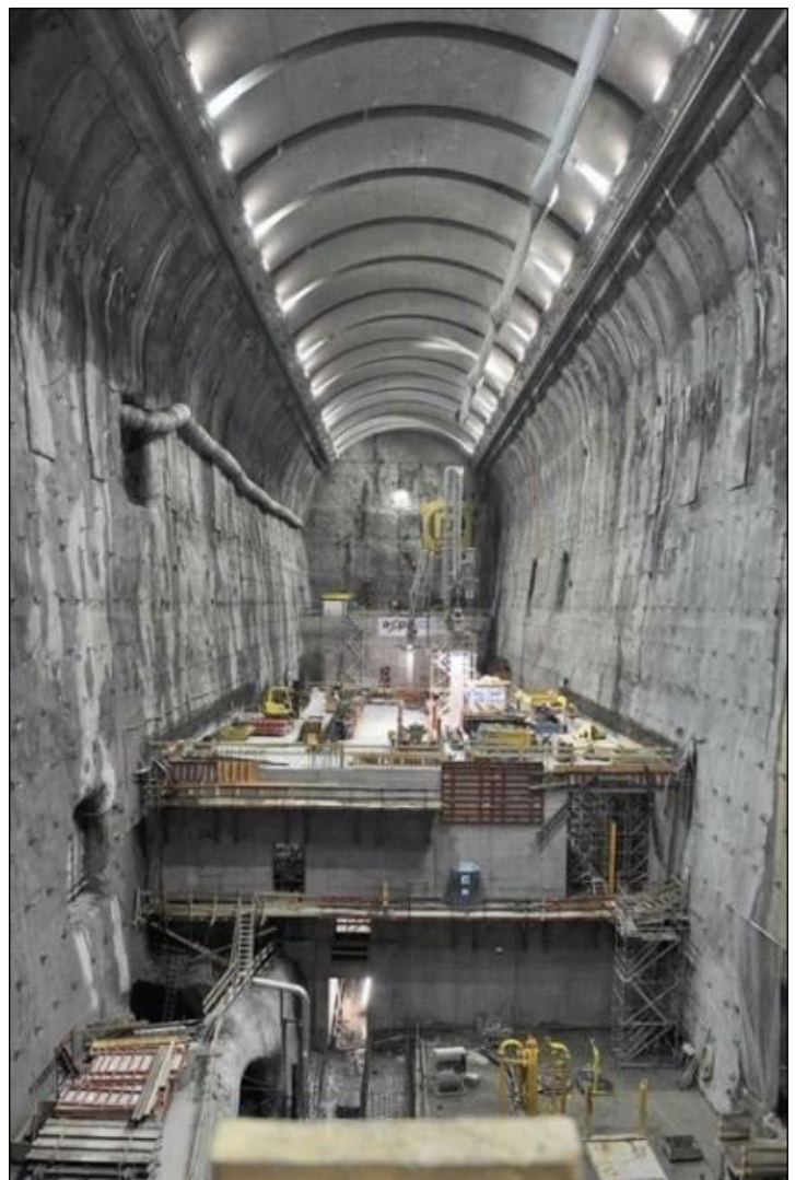
Fertig ausgebrochene Maschinenkaverne mit Betonarbeiten Rohbau I
