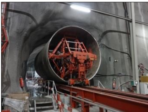
Montaggio blindaggi nel pozzo forzato (Ø = 4.20 m)
