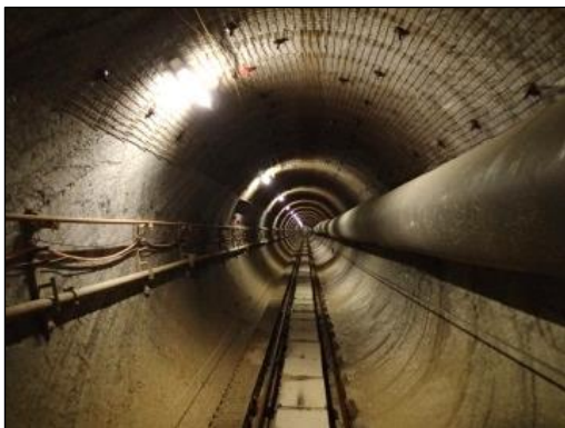
Scavo pozzo forzato inclinato (Ø = 5.20 m, 85%)
