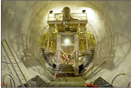
Cassero galleria sotto carico superiore (Ø=8.0 m)
