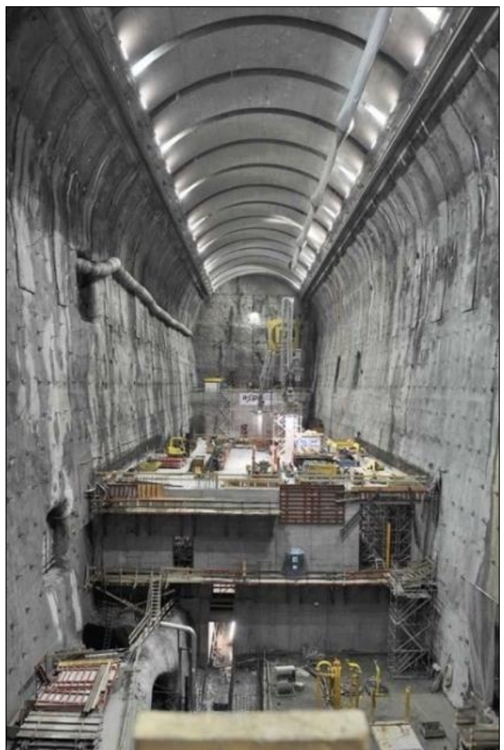
Caverna macchina scavata con lavorazione del calcestruzzo grezzo I
