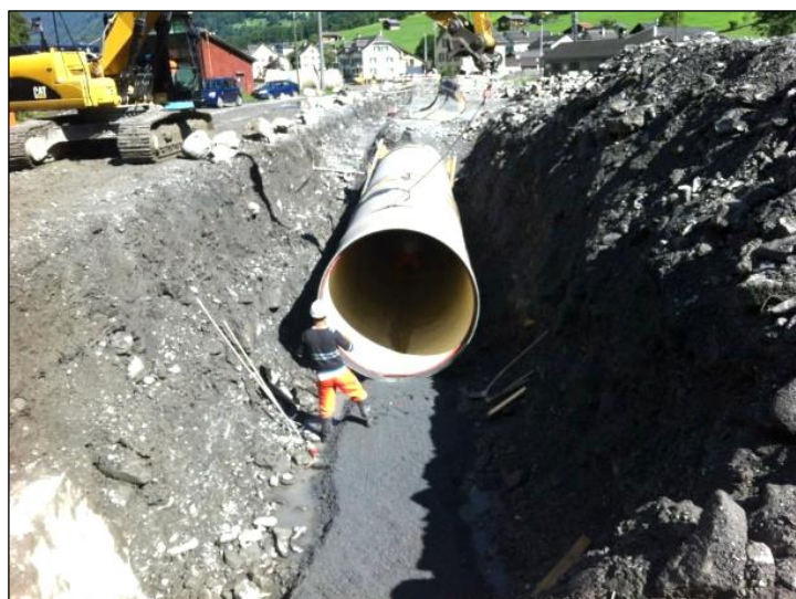
Posa della condotta forzata DN 2200 in vetroresina
