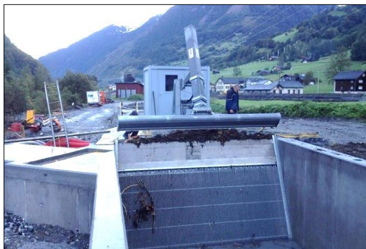
Sgrigliatore alle fine del dissabbiatore
