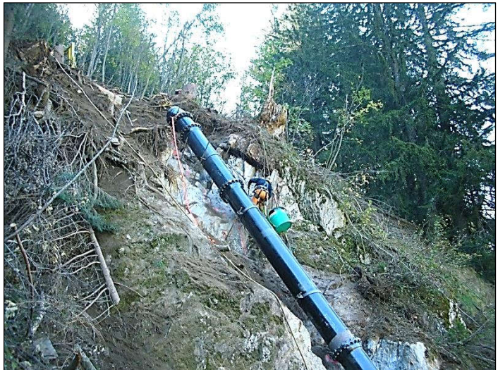
Montaggio della condotta forzata DN600 in ghisa nel pendio ripido
