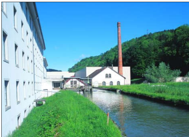
Canale a monte della centrale
