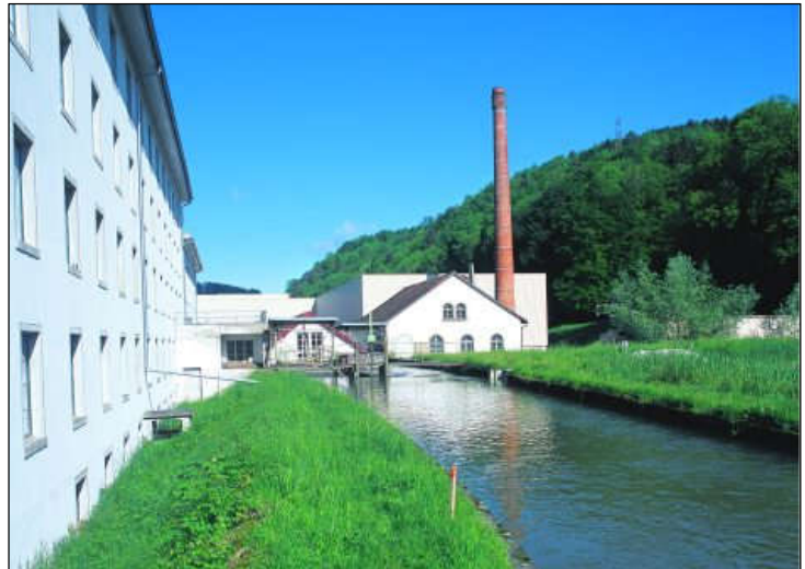
Oberwasserkanal des Kraftwerks
