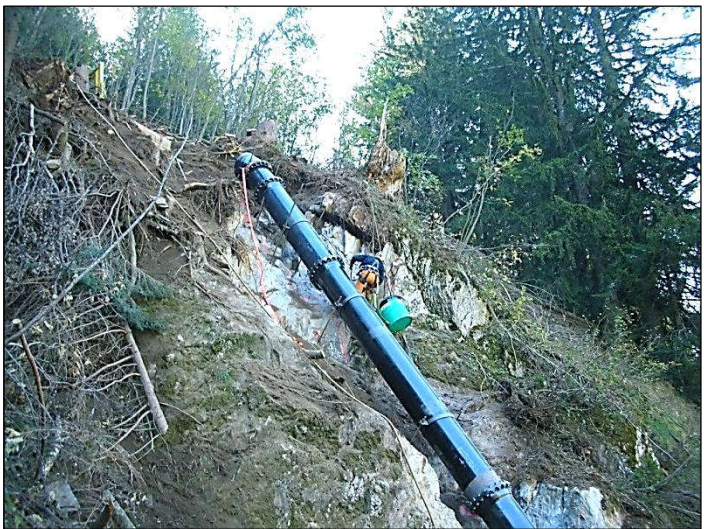
Montage der Druckleitung Dn600 in Guss in steilem Gelände
