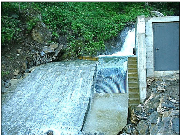
Stauwehr mit Tirolerfassung
