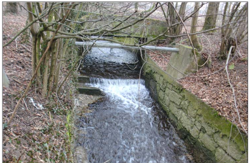
Ist-Zustand des Gretzenbach ca. 30 m oberhalb der Mündung in die Aare
