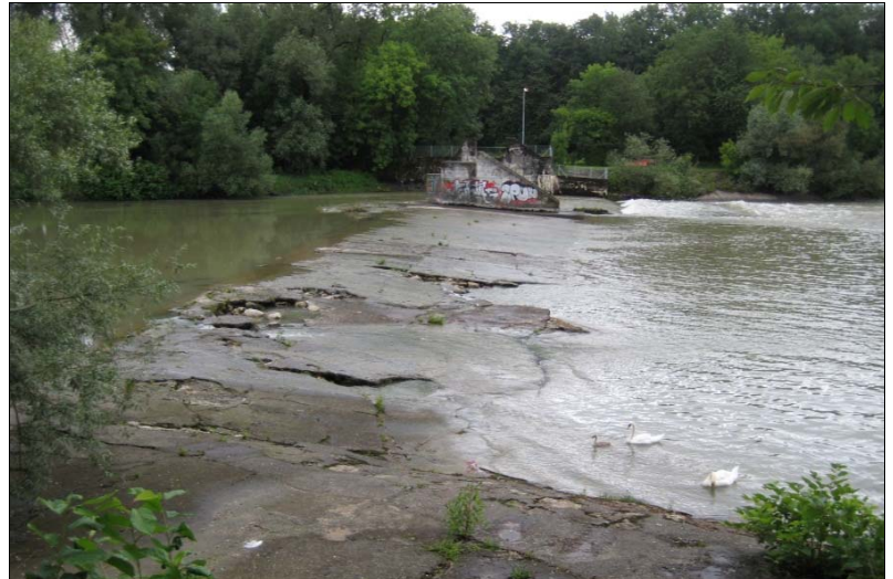
Ist-Zustand der rückzubauenden Ballyschwelle
