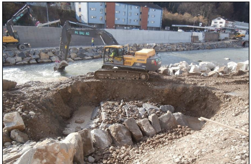
Uferanbindung einer Lenkbunne im Bau
