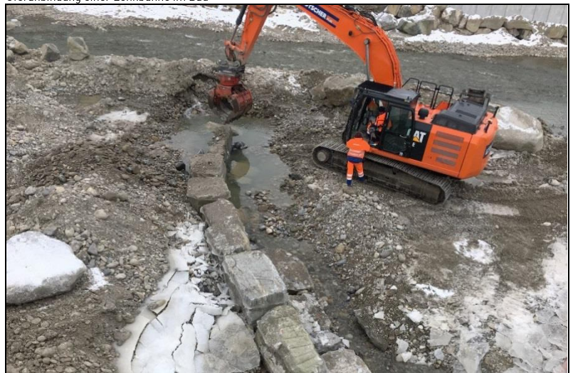
Lenkbunne im Bau
