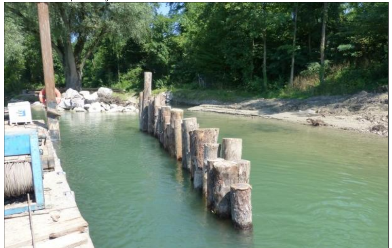
Pfahlriegel zur Optimierung der Nebenrinneanströmung (Bauzustand)
