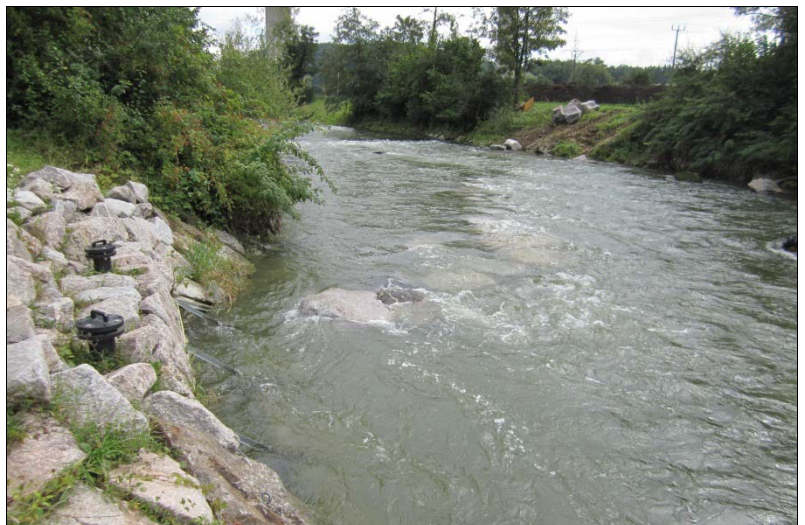
gut durchströmte Wasserfassung kurz nach Umsetzung der Optimierungsmassnahmen
