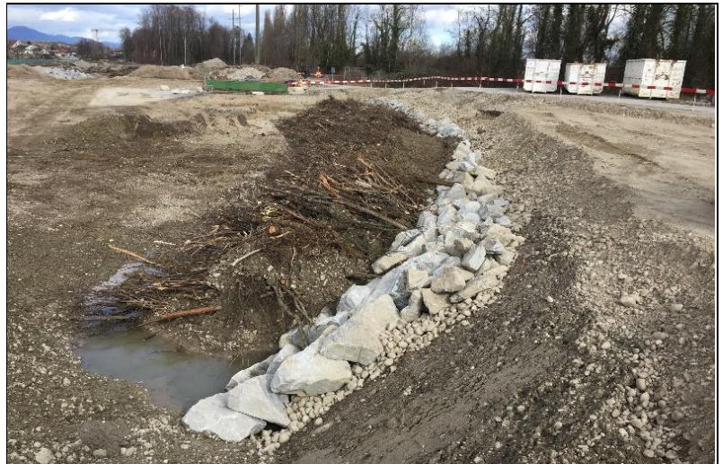
Versteckter Blocksatz mit vorgelagerter BMU im Bauzustand
