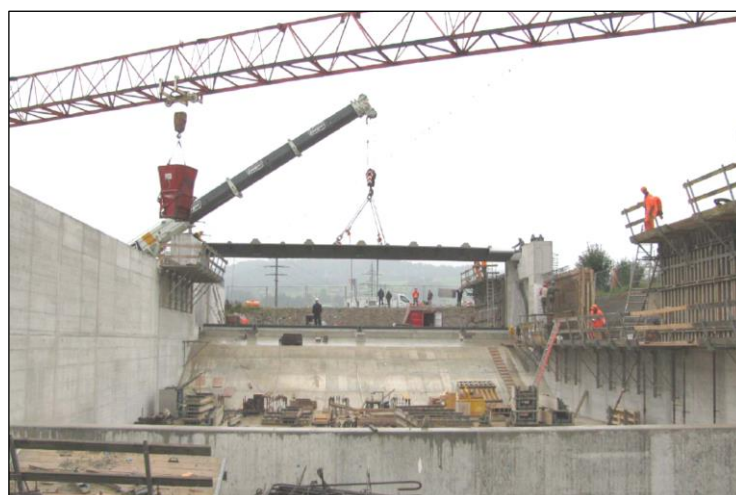
Montaggio della paratoia a ventola nel canale laterale di alimentazione al bacino di ritenzione del legname
