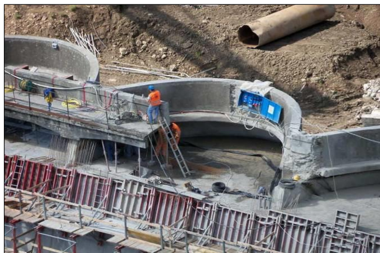
Demolizione della passerella e getto della nuova corona
