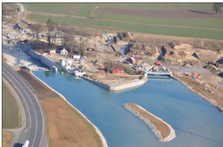
Gesamtübersicht KW Ettisbühl mit Kraftwerk, Ausleitkanal und Holzrückhaltebecken
