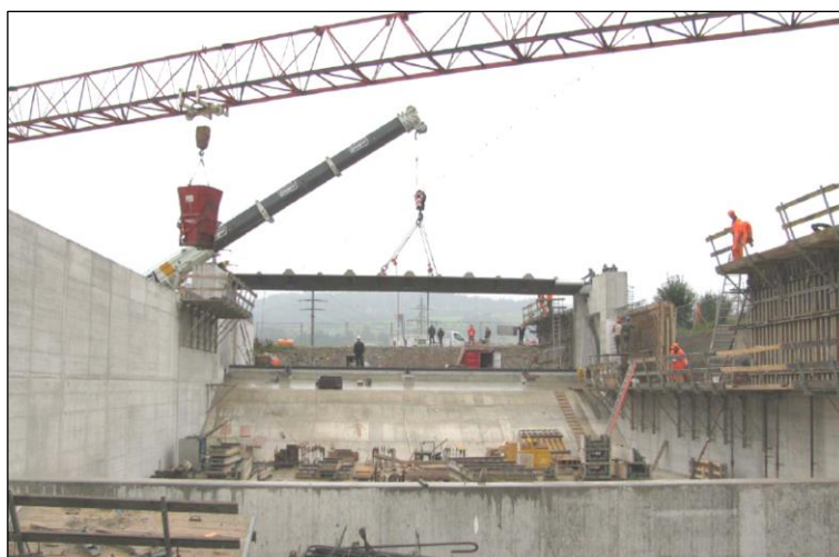
Montage der Stauklappe im Seitenkanal zum Holzrückhaltebecken
