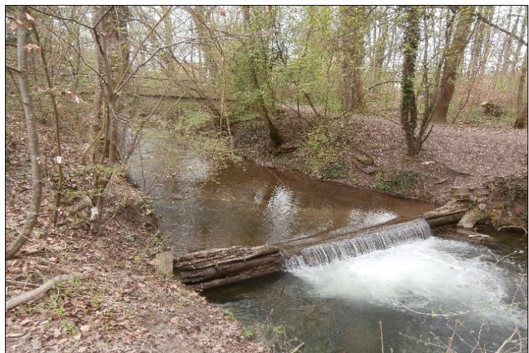
Schwelle im Ausgangszustand
