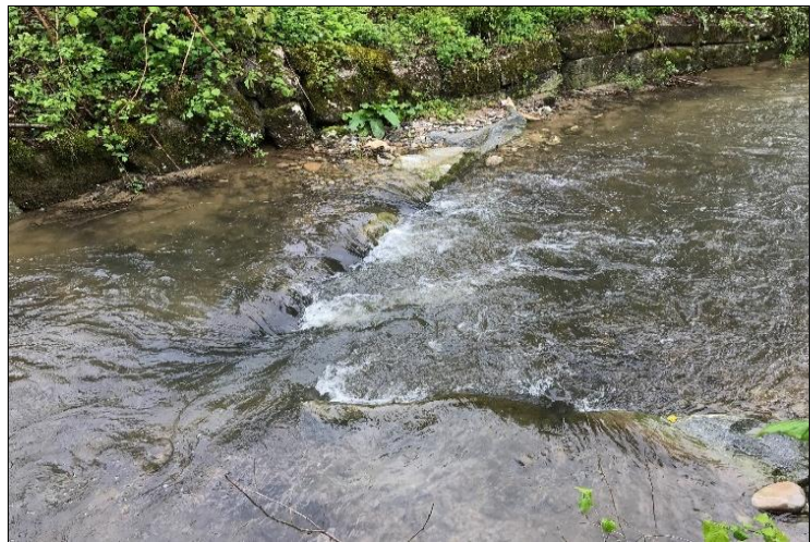
Uneingeschränkt fischgängige V-Schwelle als Ersatz für einen 30 cm hohen Absturz
