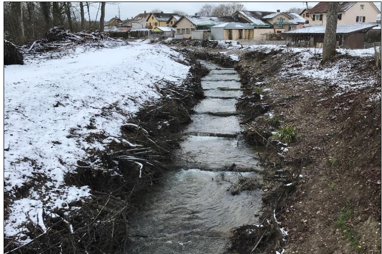
Neu erstellte Riegel-Beckenrampe zur fischgängigen Anbindung an die Emme
