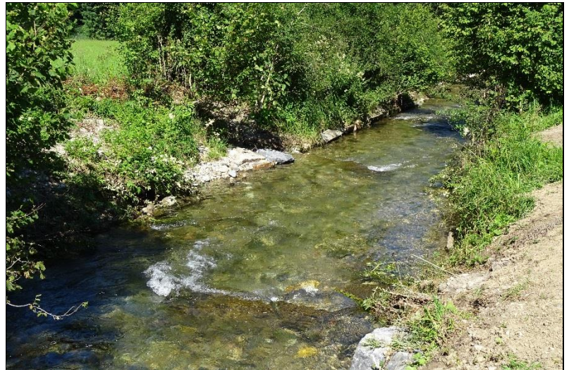
Wechselseitig angeordnete Lenkbuhnen als Schwellenersatz
