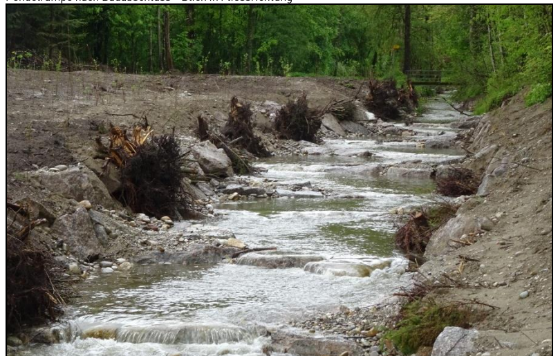
Pendelrampe nach Bauabschluss – Blick gegen die Fließrichtung
