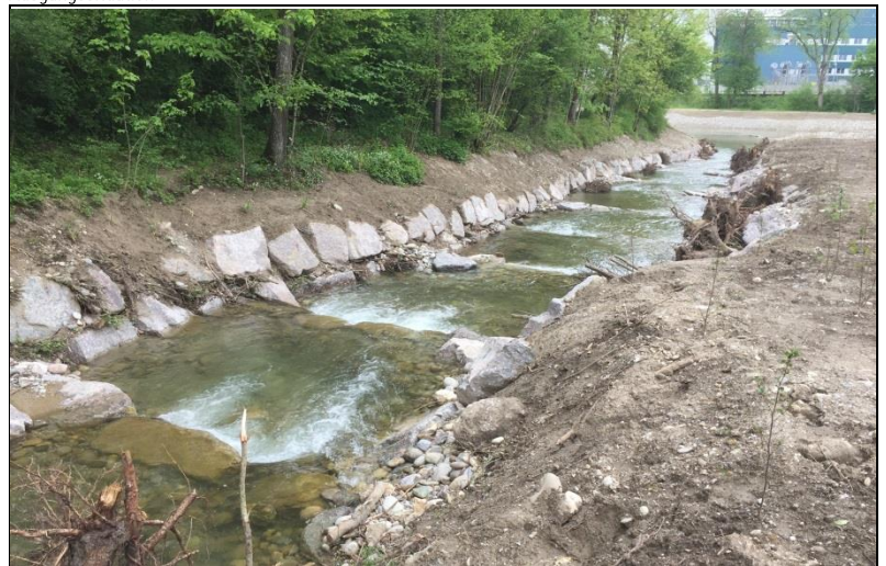
Pendelrampe nach Bauabschluss – Blick in Fließrichtung
