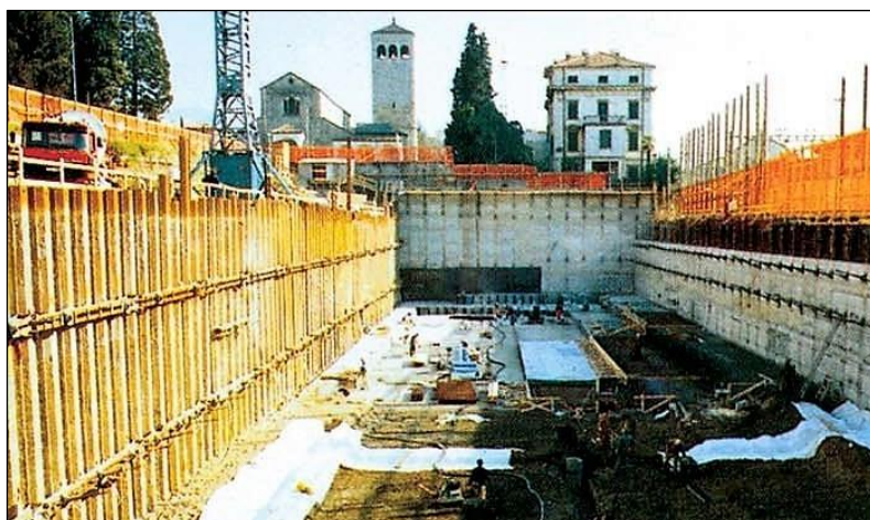
Fossa di scavo
