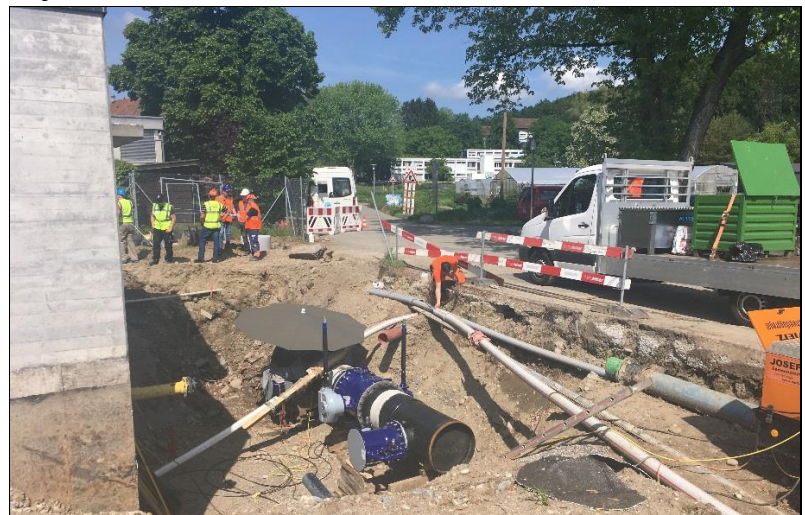
Rohrbauarbeiten am Pumpwerk Chrüzweg
