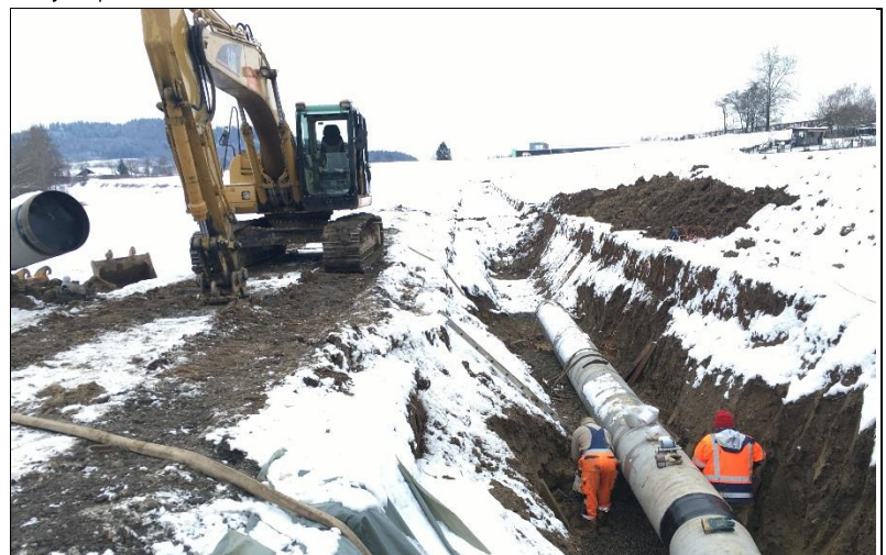
Beginn der Bauarbeiten
