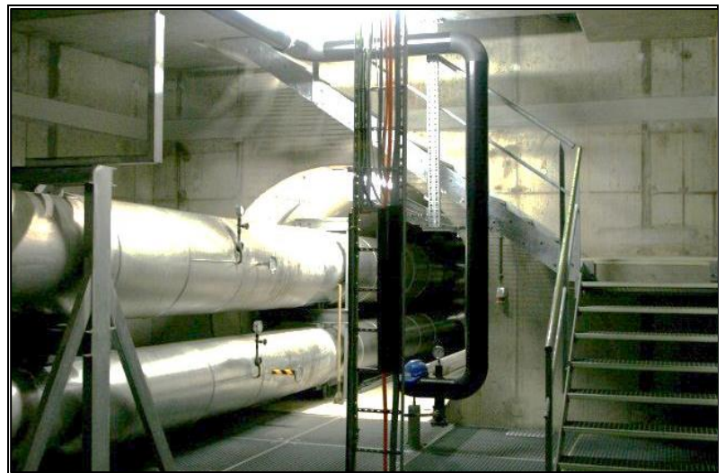
Fertiggestellter Steigschacht (untere Ebene)
