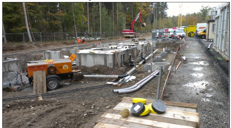
Erstellung Rückkühler, Verdichteranlagen und Speicher
