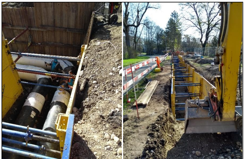
Bauarbeiten Fernwärmeleitung Ausbau West (02/2020)
