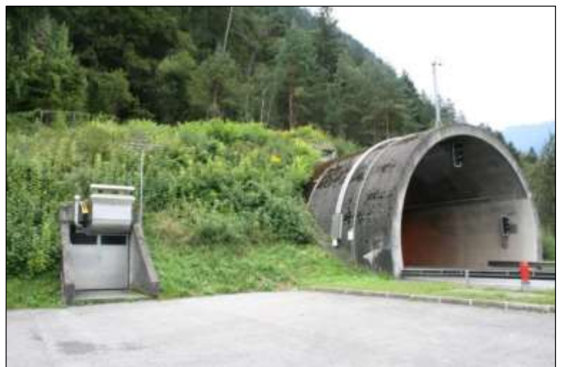
Simulation vorgesehene Sicherheitsstollen (Tunnel Isla Bella)
