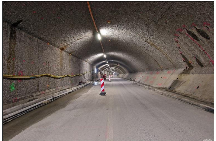
Leereräumte Allmend-Tunnelröhre Fahrtrichtung Spiez, 31.01.2018
