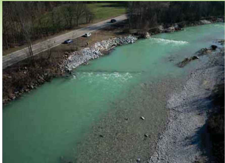
Abb. 10: Fertiggestellter Uferschutz und gleichzeitig neue Habitatstrukturen am Gleit- und Prallufer
