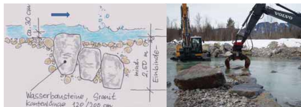
Abb. 8: Anordnung der Wasserbausteine (Granit) mit Kantenlängen bis zu 2,00m, dreireihig, zur Sicherung gegen Auskolken und Umkippen
