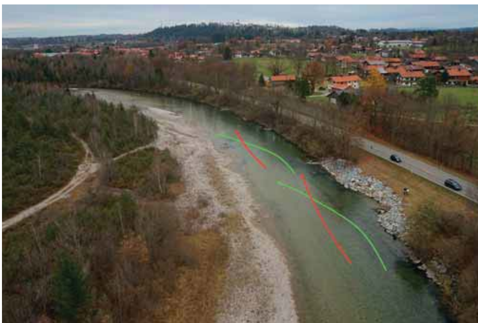
Abb. 6: Situation vor dem Einbau der Buhnen. Deutlich sichtbar der Steinverbau, der nach dem HW1999 erforderlich wurde. Die roten Pfeile stellen die schnelle oberflächennahe Strömung dar. Die grünen Pfeile stellen die sohlennahe Strömung dar, die nach und nach immer mehr Material ans Gleitufer umlagert.
