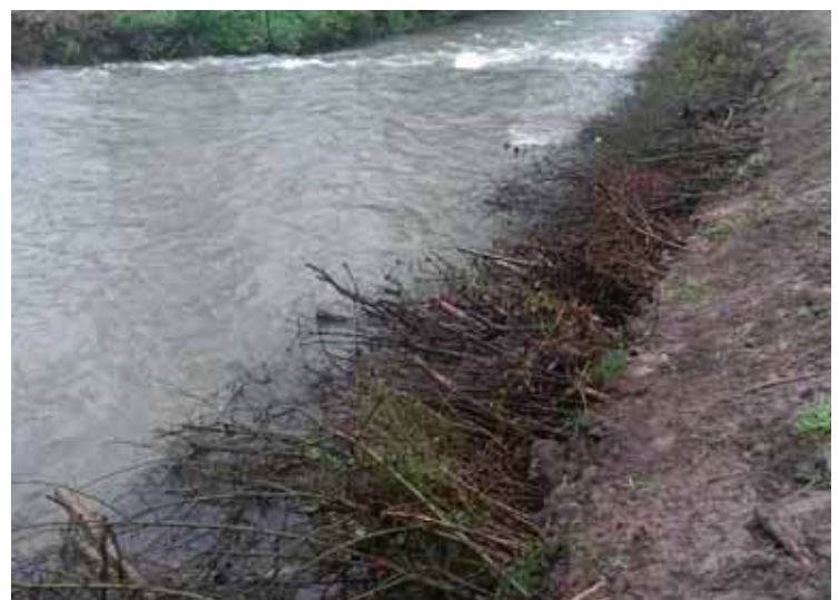
Abb. 4: Das strömungsberuhigte Wasserpolster schützt die Ufer vor Erosion und ist zugleich ein strömungsberuhigter, schattiger Fischunterstand.
