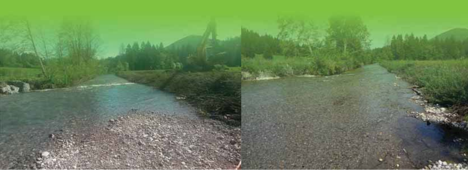
Abb. 5: Blick in Fließrichtung – Aufnahme nach Fertigstellung und im August desselben Jahres
