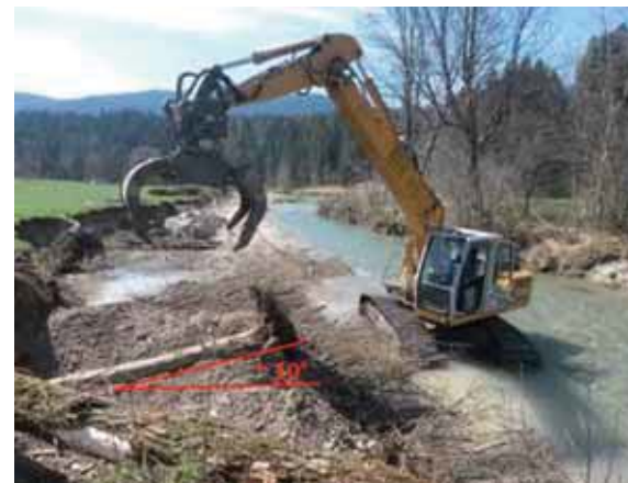
Abb. 2: Blick gegen die Fließrichtung; deutlich sichtbar sind die Ufererosionen des Hochwassers. Der Einbau der ersten Gehölzlagen hat begonnen.
