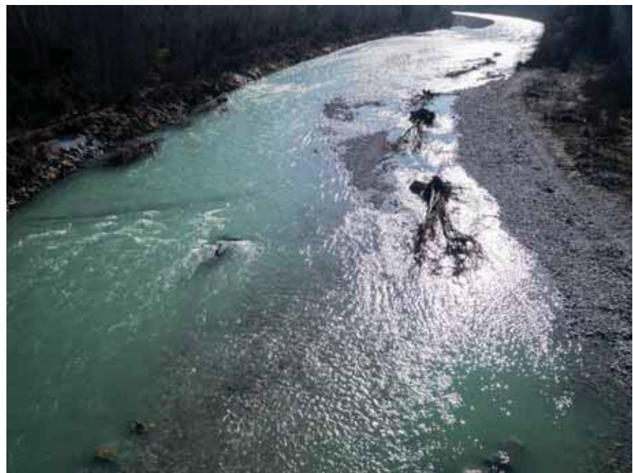
Abb. 10: Fertiggestellter Uferschutz und gleichzeitig neue Habitatstrukturen am Gleit- und Prallufer
