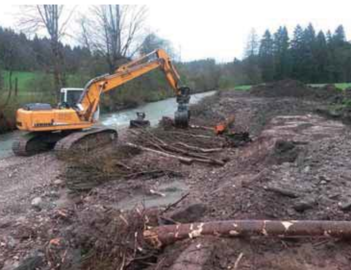
Abb. 3: Lagenweiser Einbau (Blick in Fließrichtung)
