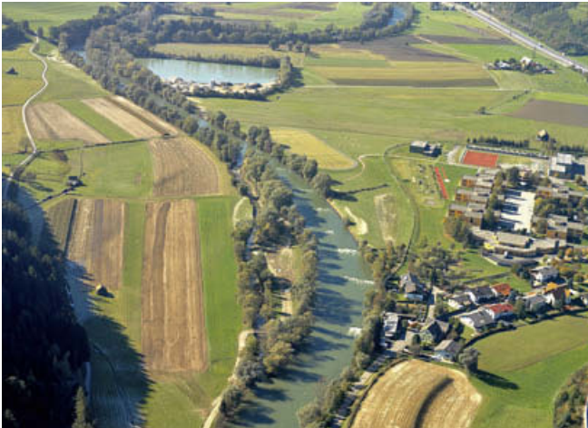
Abb. 3: Lenkbuhnen zum Schutz eines Prallufers der Mur bei St. Michael/Steiermark (Foto: G. Hauer, Graz)
