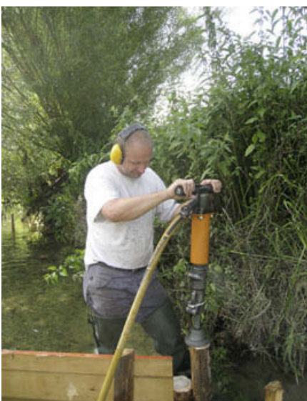
Abb. 11: Einbau von Lenkbuhnen aus Fichtenspaltpfählen mit dem Presslufthammer (links). Schaltafeln dienen als „Schablone“ (Mitte). Die Höhenlage wurde so gewählt, dass die Lenkbuhnen bis auf die Einbindung ins Ufer bei Niedrigwasser überströmt wurden (rechts).
