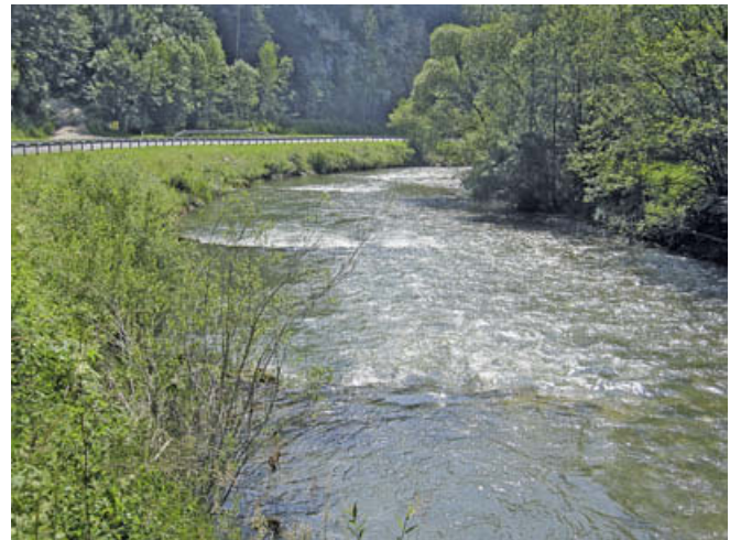
Abb. 2: Lenkbuhnen zum Schutz eines Prallufers der Mürz/Steiermark. Die Lenkbuhnen schließen untermittelbar an den bestehenden Blocksatz an, der vollständig erhalten werden konnte und seit dem Einbau stabil ist.
