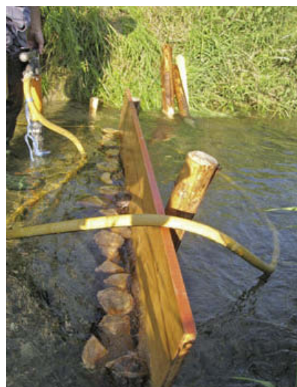
Abb. 11: Einbau von Lenkbuhnen aus Fichtenspaltpfählen mit dem Presslufthammer (links). Schaltafeln dienen als „Schablone“ (Mitte). Die Höhenlage wurde so gewählt, dass die Lenkbuhnen bis auf die Einbindung ins Ufer bei Niedrigwasser überströmt wurden (rechts).
