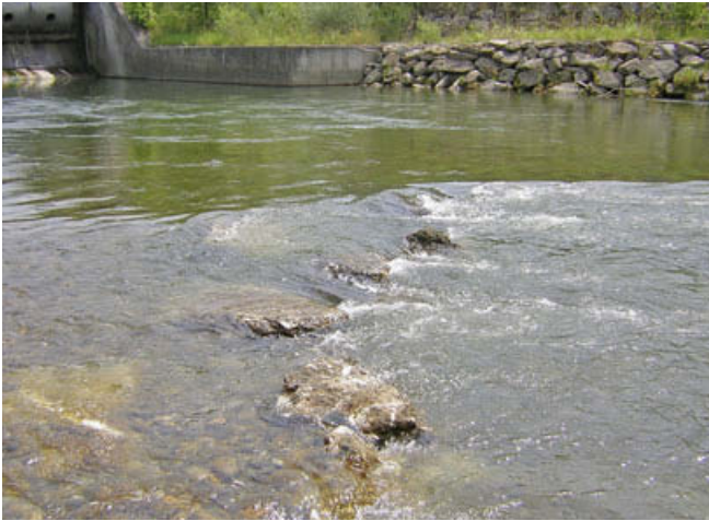
Abb. 9: Unterwasseransicht des Müritzkraftwerks Trieb mit Lenkbuhne im Vordergrund. Anhand der Verfärbungen der Betonmauer am linken Ufer ist noch gut das lange Zeit im Mittel rund 80 cm höher stehende Unterwasser zu erkennen [3, 5]
