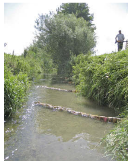
Abb. 11: Einbau von Lenkbuhnen aus Fichtenspaltpfählen mit dem Presslufthammer (links). Schaltafeln dienen als „Schablone“ (Mitte). Die Höhenlage wurde so gewählt, dass die Lenkbuhnen bis auf die Einbindung ins Ufer bei Niedrigwasser überströmt wurden (rechts).
