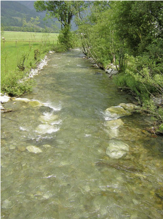
Abb. 6: Inklinanter Strömungstrichter zum Schutz der Widerlager einer oberhalb liegenden Brücke und zur Entlastung der Ufer unterhalb
