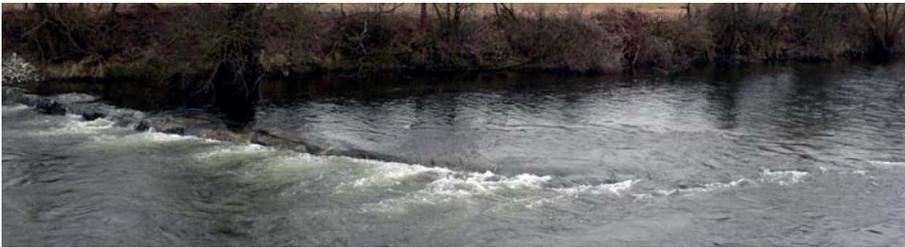
**Bild 3. Inklinante Lenkbuhne in der Mur bei St. Michael/Obersteiermark bei Niedrigwasserabfluss (Foto: Otmar Grober).**
