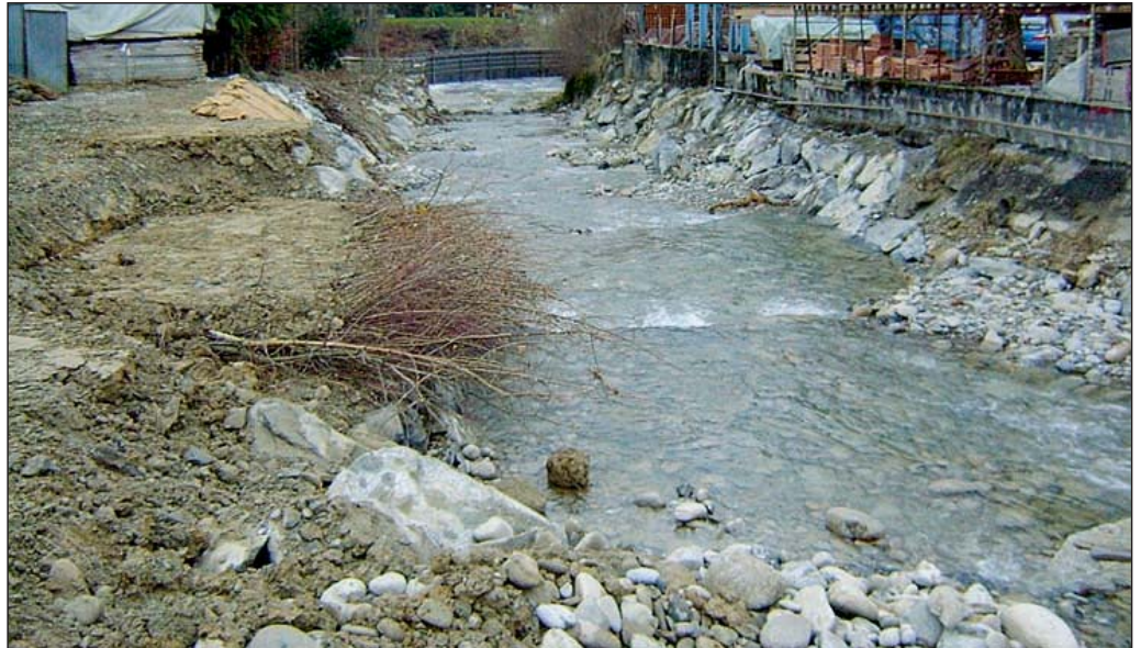
Foto 6: Lokale Böschungssicherung mit Buschlagen (Bauzustand).
