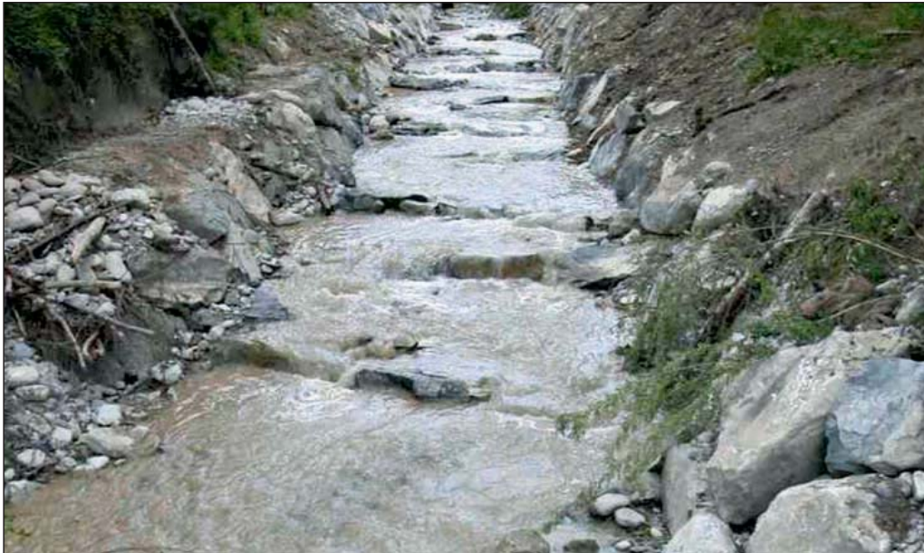
Foto 2: Erstauführung der Pendelrampe unmittelbar nach Fertigstellung im Mai 2007. Photo 2: Première mise en service de la rampe pendulaire directement après son achèvement en mai 2007.
