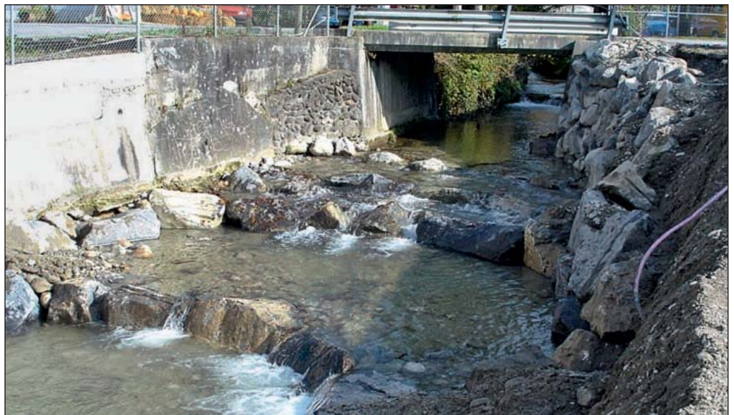
Foto 4: Riegel als Rauheitselemente zur Verringerung der Fließgeschwindigkeit im Zulaufbereich zur Pendelrampe inklusive linksufriger Verbreiterung.
