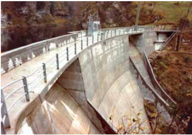
Bild 10 (oben). Verkleidete Mauer Muslen. Bild 11 (rechts). Verkleidung Mauer Muslen.
