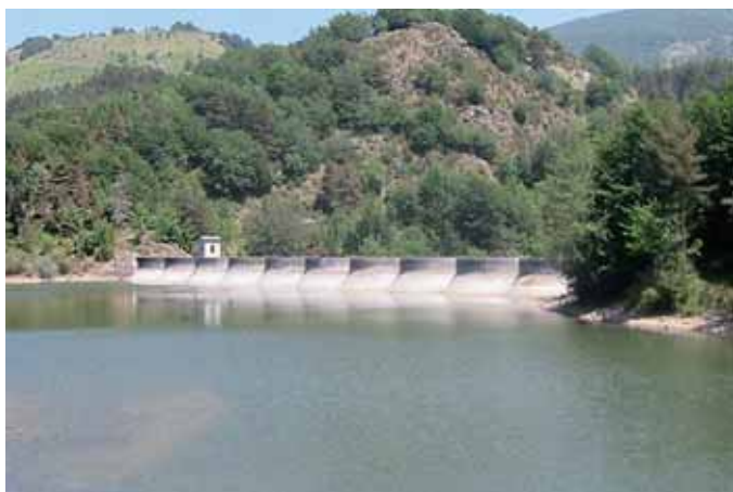
Bild 3. Gewölbepeserre Pian Sapeio.
