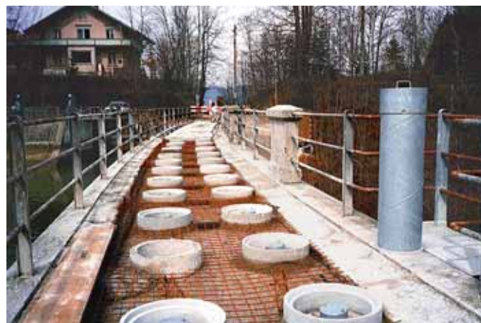
Bild 4. kronenbalken mit Ankerköpfen.
