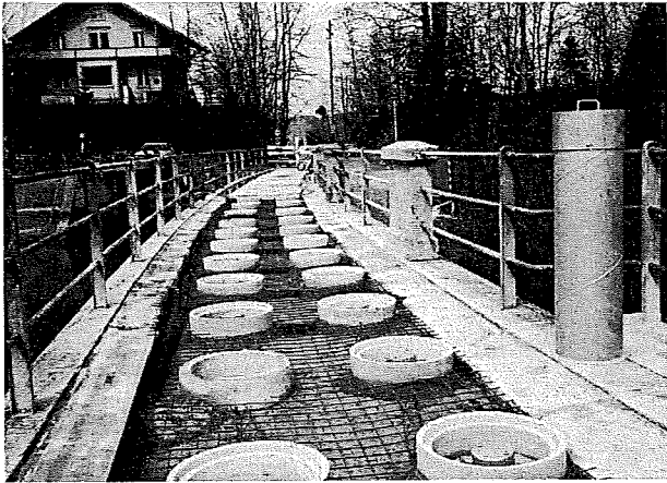
Bild 6. Mauerkrone der östlichen Abschlussmauer mit Kontrollschächten.
