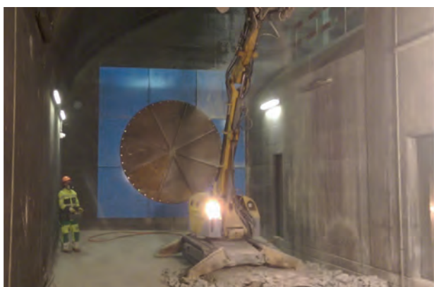
Figure 4 : Démolition en centrale de ventilation
