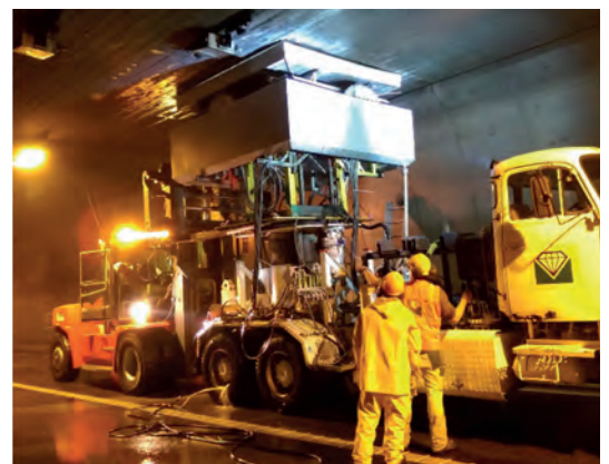
Figure 2 : Dépose du bloc de dalle intermédiaire scié
