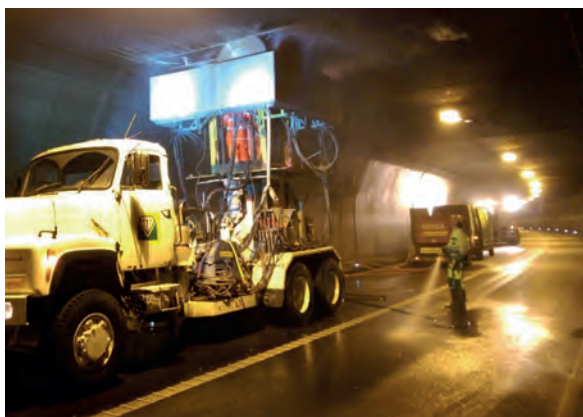
Figure 1 : Sciage d'une trappe d'air vicié
