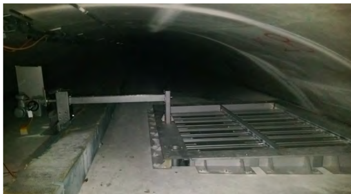
Figure 4 : Nouveau clapet d'extraction d'air vicié
