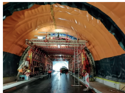
Bétonnage de la voûte
