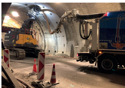
Démolition par fraisage
