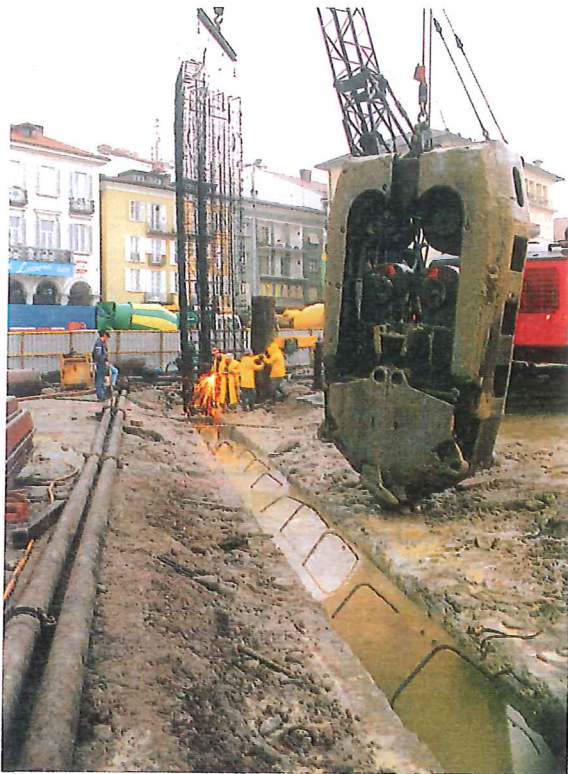
Figura 3 Scavo di approfondimento tra le so- lette di contrasto della paratia
