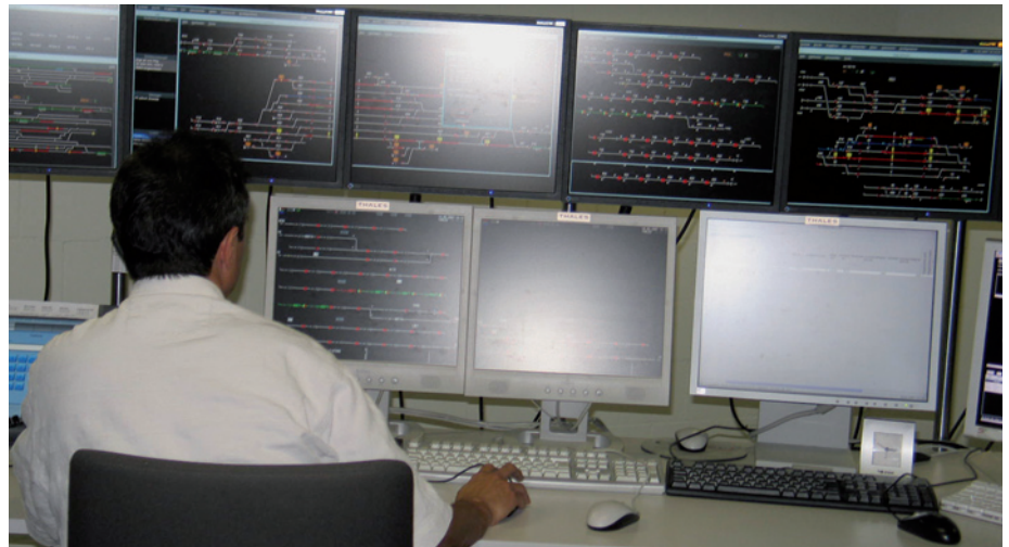
Tunneloperateur im Einsatz.
