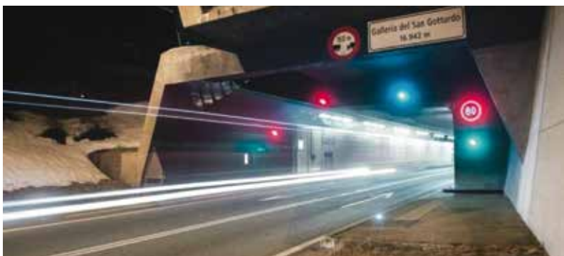
3. Il portale Sud del traforo del San Gottardo
