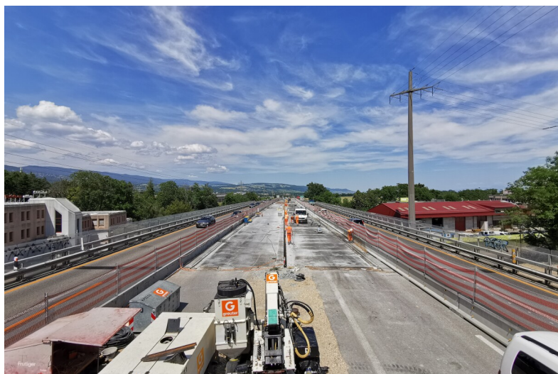
Ricostruzione spartitraffico con impalcato in CFAP e nuove barriere laterali
