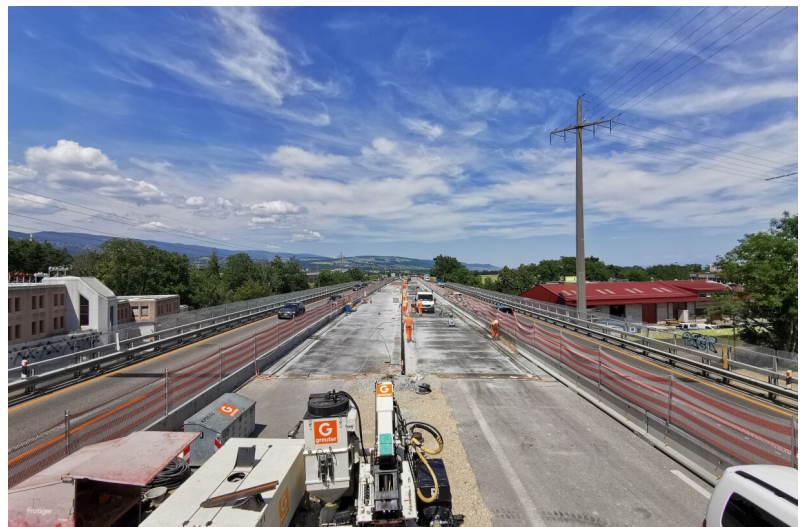
Wiederaufbau des Mittelstreifens mit UHFB-Fahrbahnplatte und neuen Randbefestigungen
