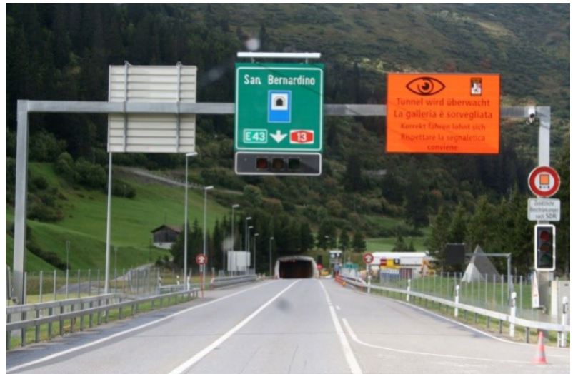
Nordportal San Bernardino Tunnel
