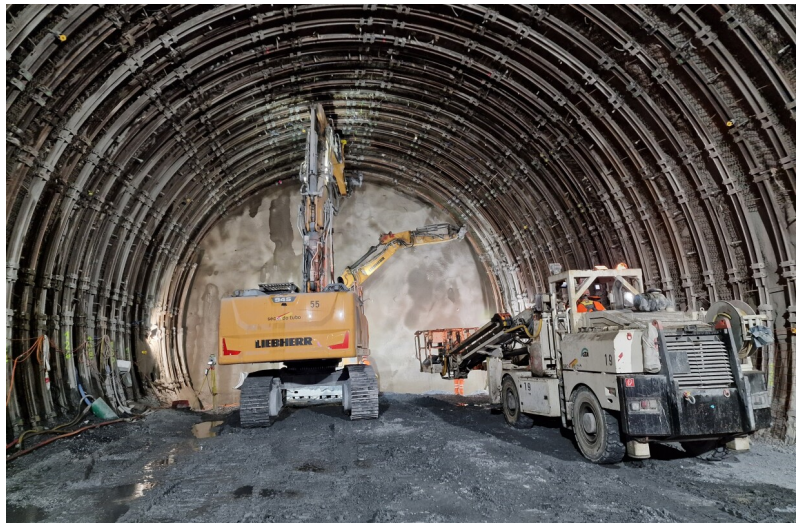
Avancement conventionnel d'une zone de perturbation d'environ 350 m de long avec soutènement flexible en voûte
