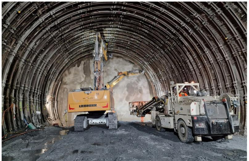
Avanzamento convenzionale in una zona di disturbo lunga circa 350 m con sostegno ad arco flessibile
