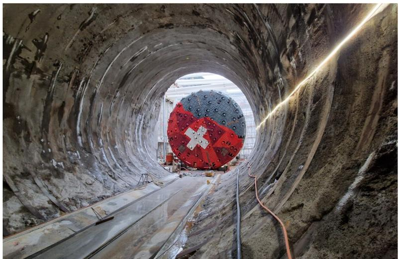
Montaggio della fresa davanti al tubo di partenza
