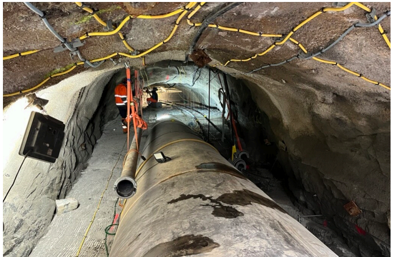
Pose des conduites d'injection et des ancres de précontrainte dans la galerie du tronçon à faible pente
