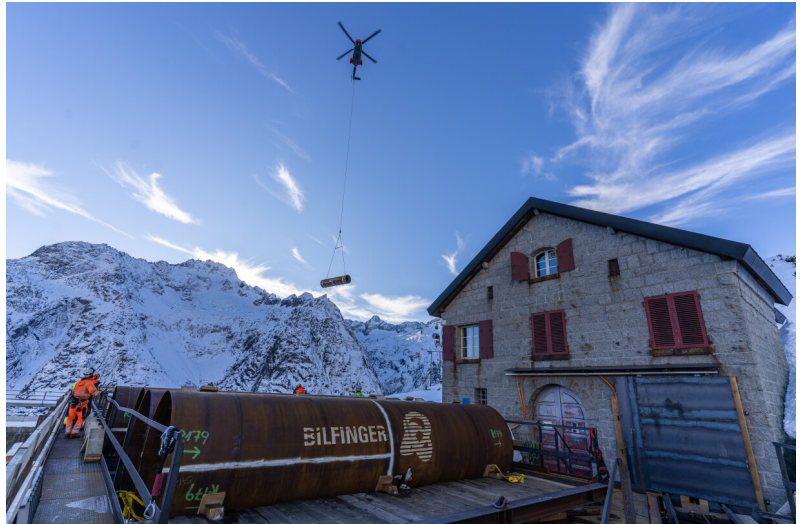
Transport des tuyaux à l'aide d'un hélicoptère pour charges lourdes
