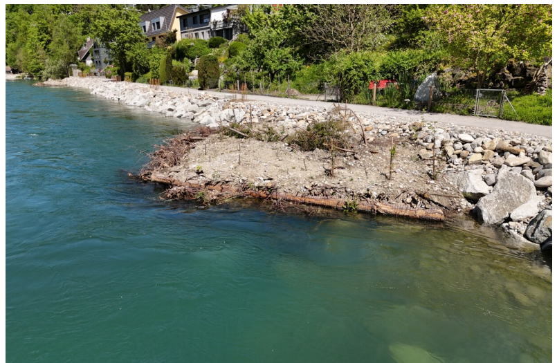
Neuer Blocksatz mit vorgelagerten Strukturmassnahmen
