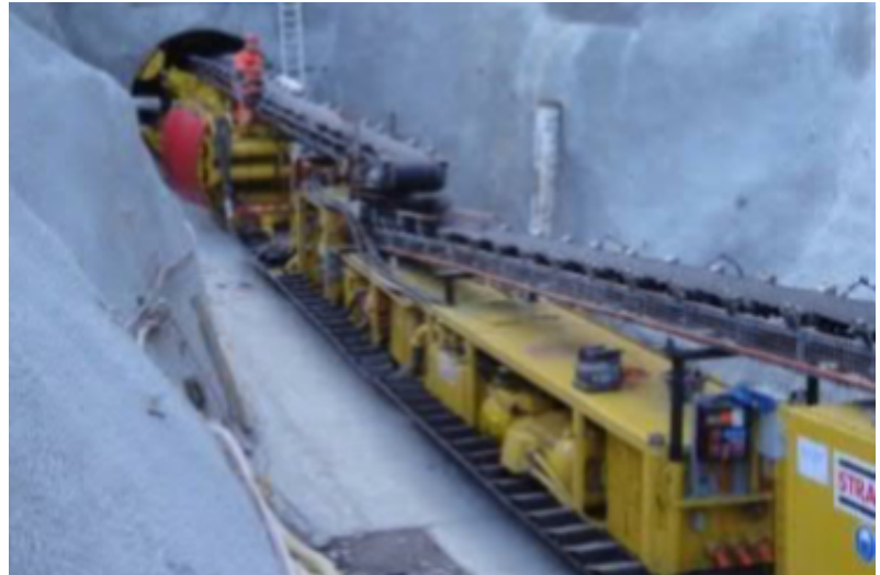
TBM Ø 3.00 m per scavo tunnel/pozzo piezometrico
