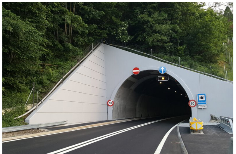
Nordportal, Sanierte Tunnelröhre, 12.05.2019
