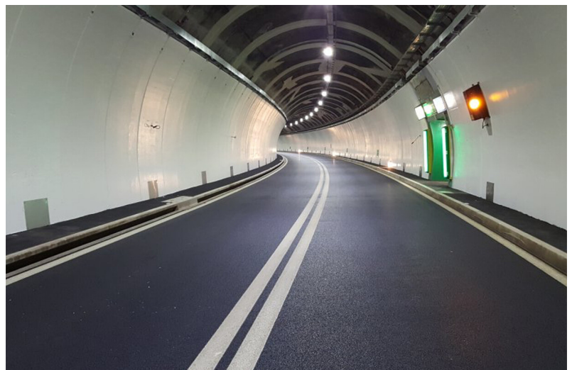
Fahrraum mit Querverbindung zum SiSto
