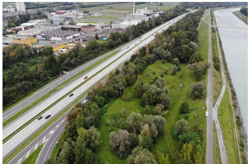
Rheindamm, Buchs SG, Vfa-Energiebrücke und Industrie
