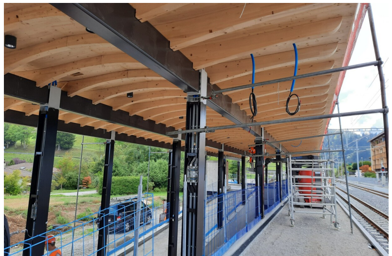
Travaux électriques sur marquise
