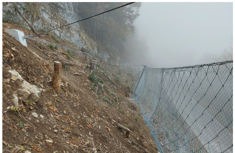
Abtrag zerklüfteten Felskopf während dem Bau
