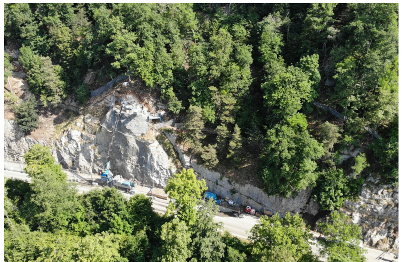
Abtrag zerklüfteten Felskopf während dem Bau
