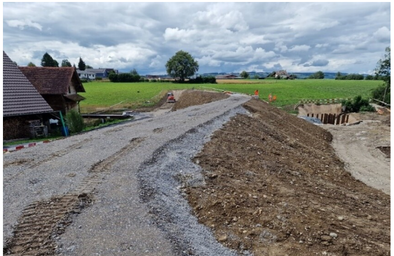
Dammkrone mit überdecktem Erosionsschutz
