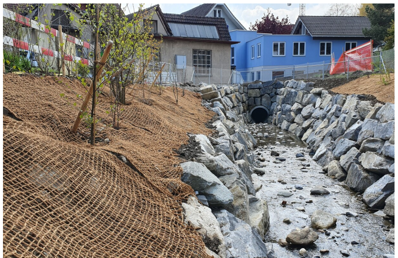
Einlaufbereich des eingedolten Bachleitung
